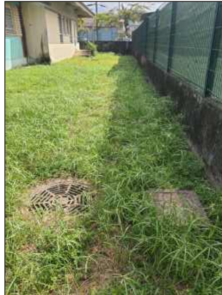
Passage du canal de collecte Extrémité Est du site Vue vers le Nord
