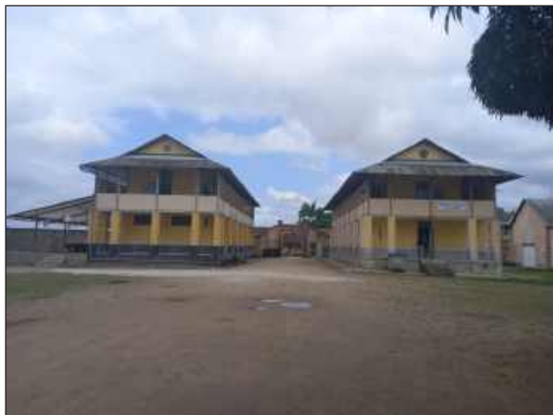
Bâtiments du CIAP (à gauche) et de la Bibliothèque actuelle (à droite) à l'entrée du site
