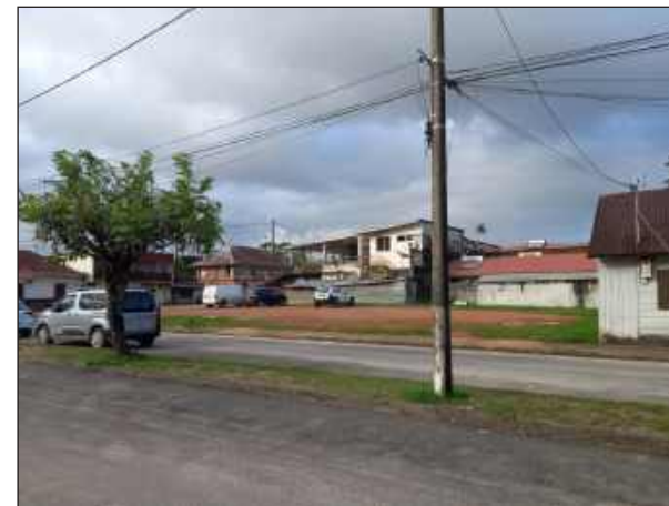
Zone de stationnement au Nord - rue Victor Hugo, vue vers le Nord
