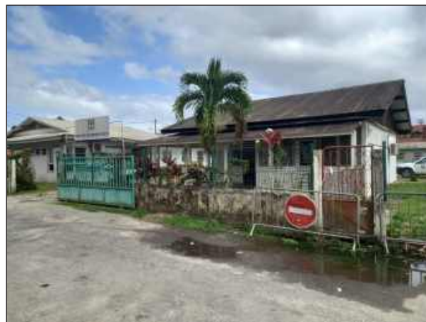
Le site vu depuis l'angle Sud-Ouest
