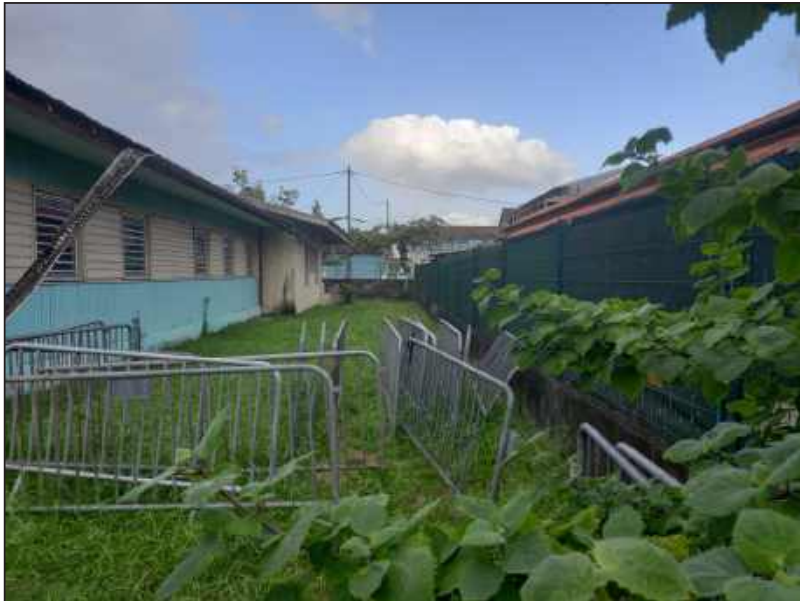
Passage du canal de collecte Extrémité Est du site Depuis place du Marché, vue vers le Nord
