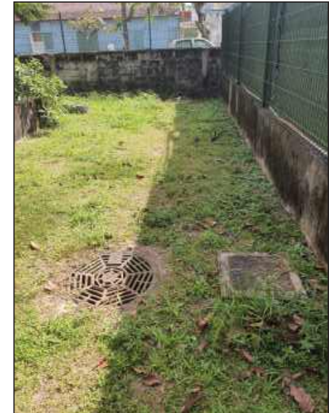
Passage du canal de collecte Angle Nord-Est du site Vue vers le Nord
