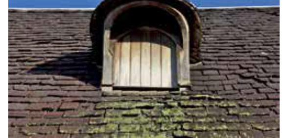
Lucarne réalisée par les Compagnons du Devoir et du Tour de France, Régis Nolent © CIAP Saint-Laurent-du-Maroni
