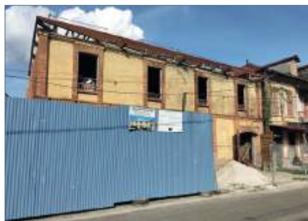
Réhabilitation en cours au 5 rue Marceau
