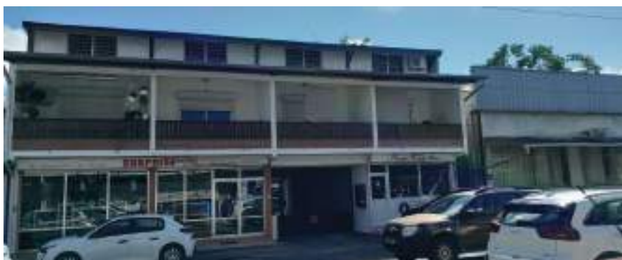
Copropriété SDC de l'immeuble 11 Rue Montravel, Saint-Laurent-Du-Maroni, 2023
