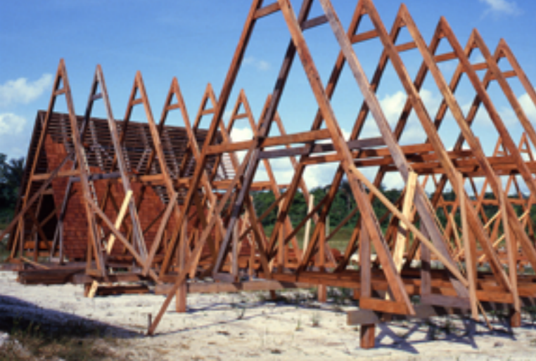
Les maisons de La Charbonnière en construction, 1985
