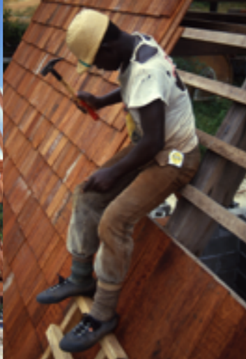
La pose des bardeaux
