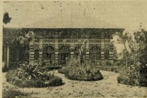
Vue de l'ancienne résidence du Directeur de l'Administration Pénitentiaire
